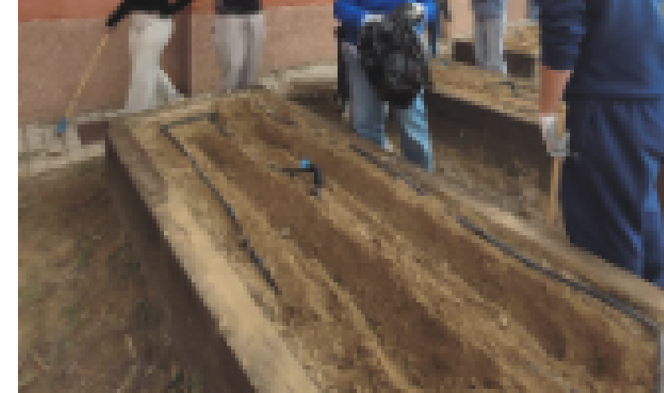
Instalación del riego
