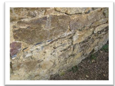
Muro de emplazamiento con foso
