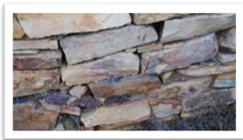
Muro de castro
