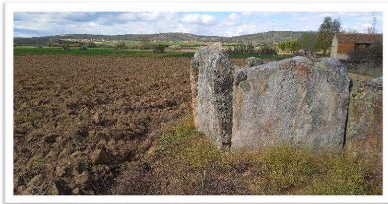
Estado actual del dolmen
